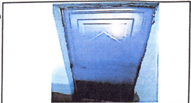
FOTO 5: Mantenimiento a estructura (lijado, cambio de tubo , cepillado, sujeciones, aplicación de pintura) modulo de aula 5
