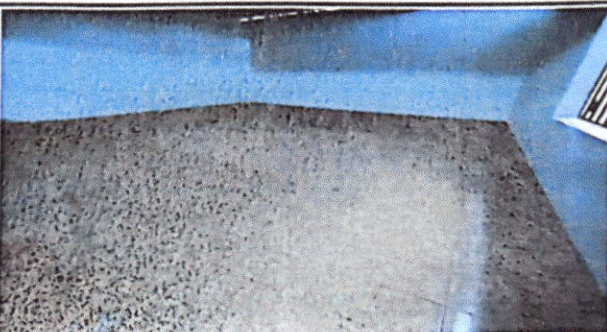
FOTO 6: Sustitución de piso de cemento lizo por piso ceramico en modulo de aula 5
