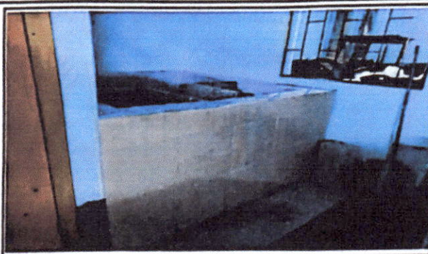
FOTO 2: Sustitución de pila de cemento de dos lavadero
